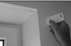
Sender in die Nähe des Netzanschlusskabels halten, an dem das SF55T angeschlossen ist.
