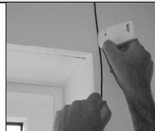
Einen ca. 50cm langen, isolierten Draht z.B. 1,5<sup>2</sup> über die Stelle halten, hinter der sich das SF55T befindet. Sender direkt an den Draht halten.
